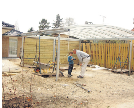
Opsætning af carport står vi selv for. To dages arbejde og så er den stort set i vinkel, og vi kan få lagt fliser.
